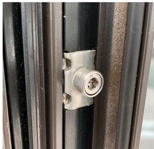
El ajuste de los puntos de bloqueo es el método predeterminado para ajustar la compresión de la hoja. Si se desea un ajuste adicional de la compresión, consulta la siguiente sección: “Ajuste del retenedor del marco”.
