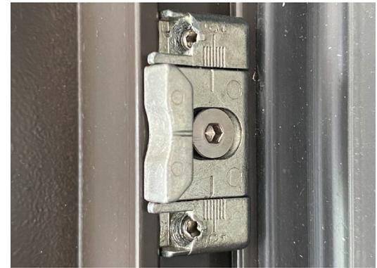
Los sujetadores individuales se pueden ajustar para proporcionar diferentes niveles de compresión de la puerta cuando la ventana está cerrada y bloqueada.
