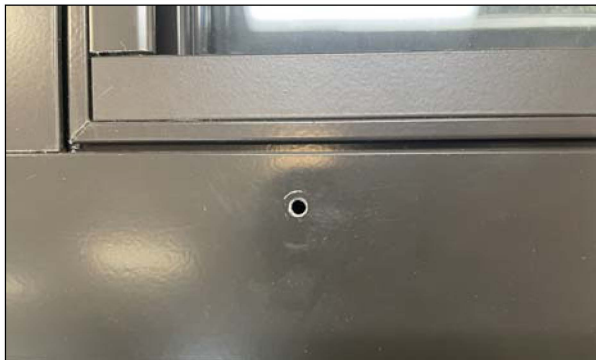
移除篩網夾後的裸露3/18"孔
